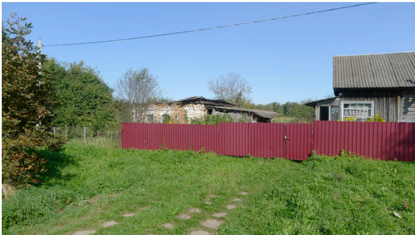
Фото 1. Вид дома (слева, без крыши) в домовладении по адресу: с. Попково, № 52.
