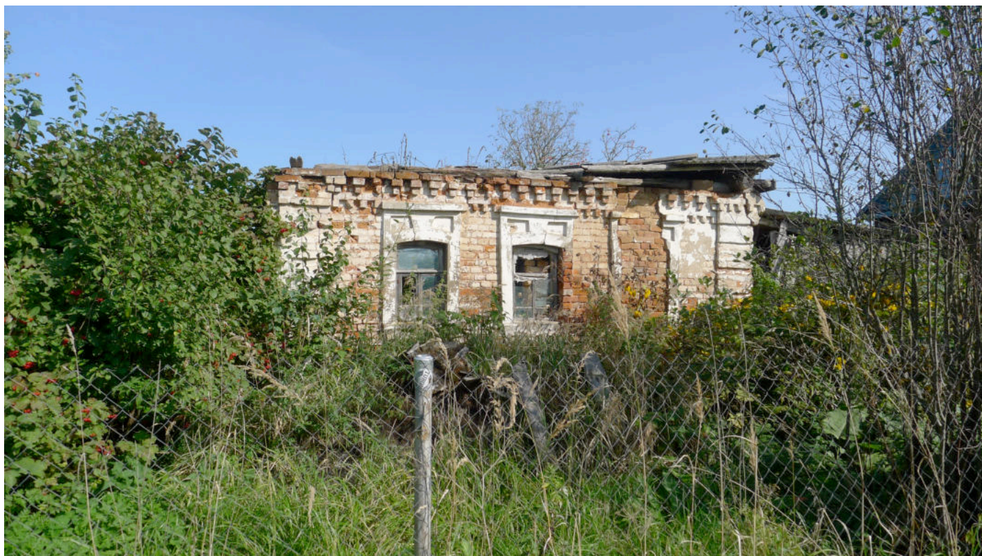
Фото 2. Уличный (западный) фасад дома.
